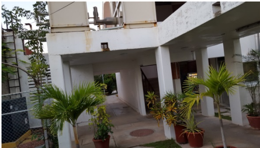
Vista cámara 5 pasillo y acceso Edif B.
