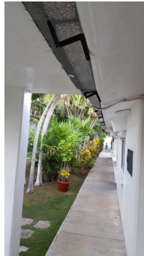
Vista cámara 6 vista acceso oficinas
