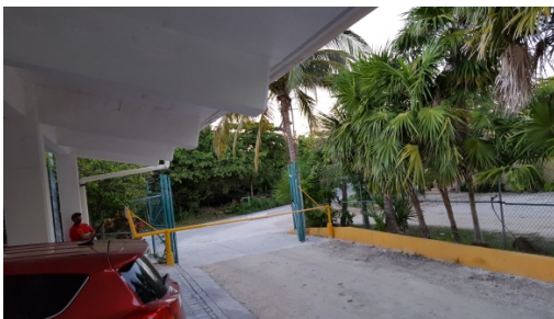
Vista de cámara(1) estacionamiento norte
