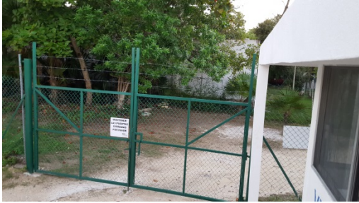
Vista cámara 3 estacionamiento sur
