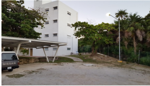
Vista cámara 4 estacionamiento sur
